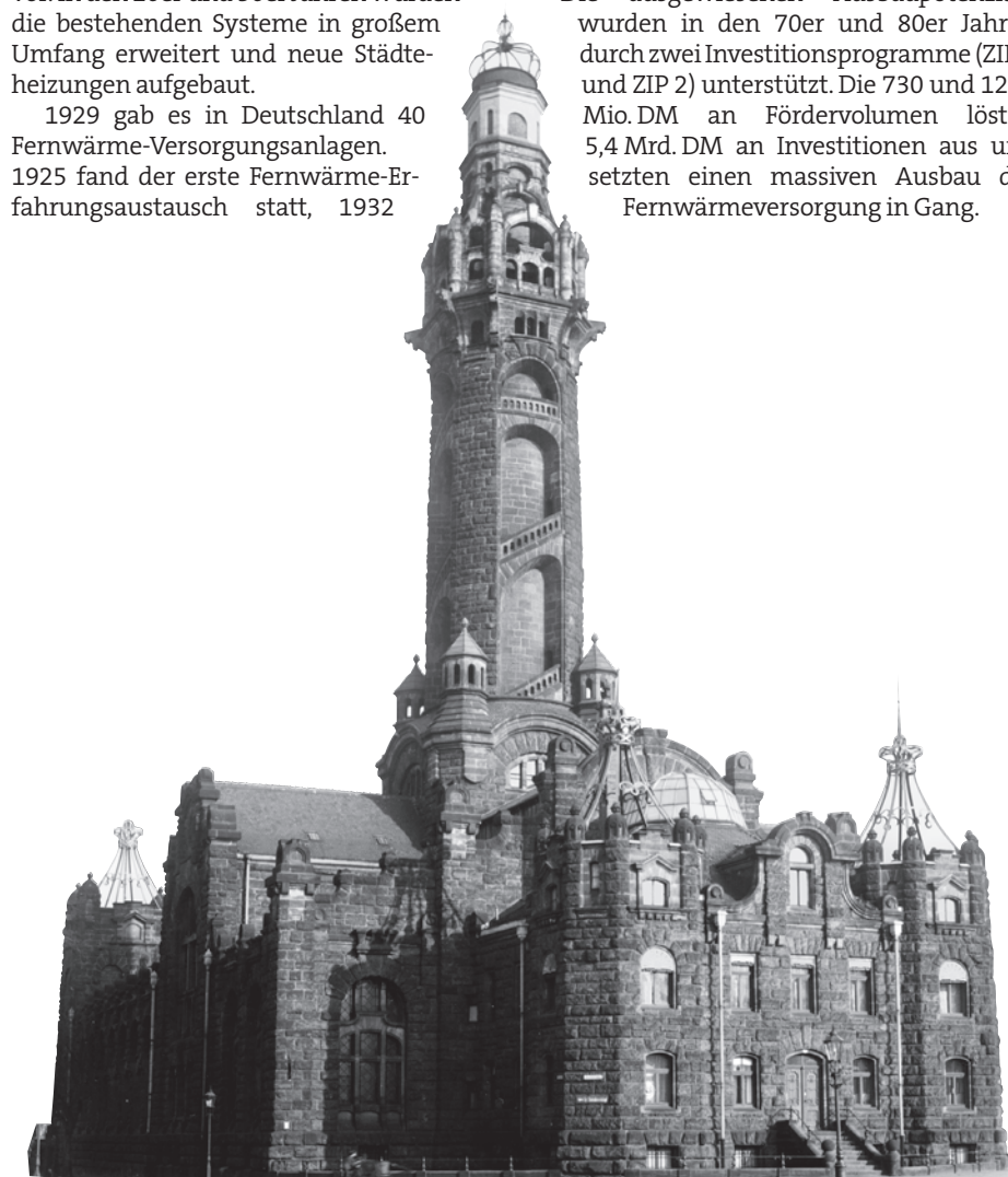
Der Anfang der »Städteheizung« in Deutschland: Mit der Inbetriebnahme des staatlichen Fernheiz- und Elektrizitätswerks Packhofstraße Ende 1900 in Dresden begann die »Städteheizung«. Bis dahin versorgten Fernheizwerke überwiegend einzelne Gebäude. In Dresden wurden erstmalig aus einem zentralen Heiz- und Kraftwerk 14 Gebäude beliefert. Erwägungen zur Architektur und Feuersicherheit waren für die Realisierung dieser Lösung ausschlaggebend.
