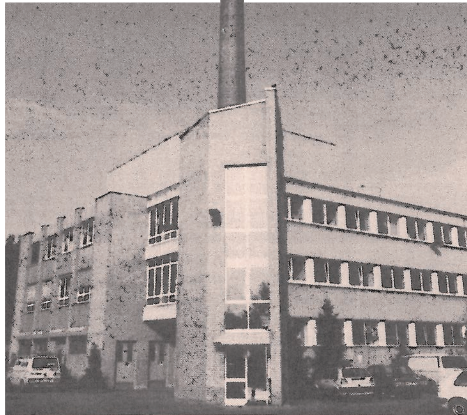
Bauhaus-Stil versus Industrie-Kathedrale: Den Wandel im Zeitablauf zeigt das 1985 in Betrieb genommene Dinslakener Heizwerk im Vergleich zum historischen Gebäude des Fernheiz- und Elektrizitätswerks Packhofstraße in Dresden (siehe Foto unten), das fast hundert Jahre früher einen Meilenstein in der Fernwärmeversorgung symbolisierte.
