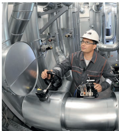
Ein Kälte-Monteur der Eins Energie: Er überprüft die Kälteversorgungstechnik des Klinikums Chemnitz.
